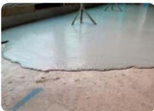
Como solución niveladora, EXCELIO® se aplica de forma adherida sobre diferentes soportes tanto en obra nueva como en rehabilitación. Su altísima fluidez garantiza una instalación sencilla y una planimetría perfecta.
