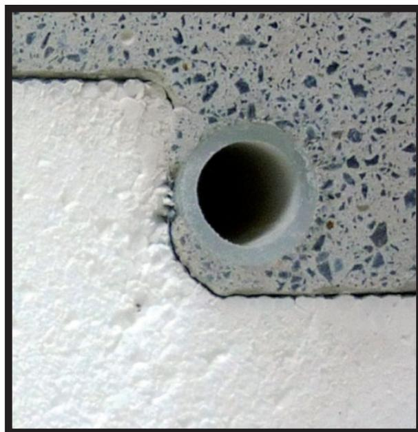
Figura 1. El mortero debe asegurar una correcta distribución del calor
