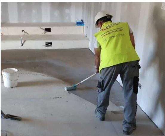
**Paso 6:** aplicación de imprimación acrílica
