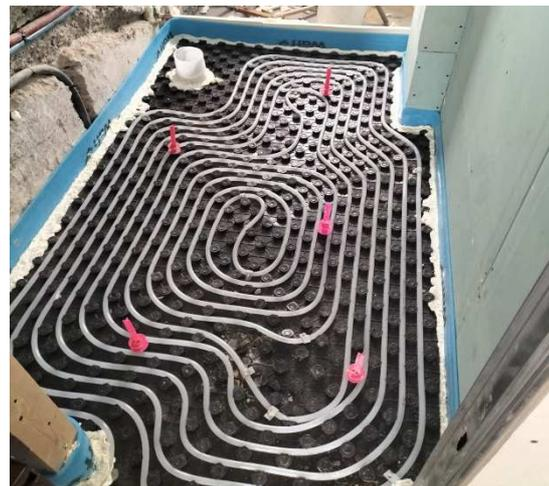
*Sellado perimetral de la instalación con espuma de poliuretano*
