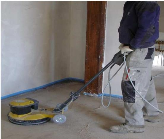
**Paso 4:** lijado, previo secado de la solera
