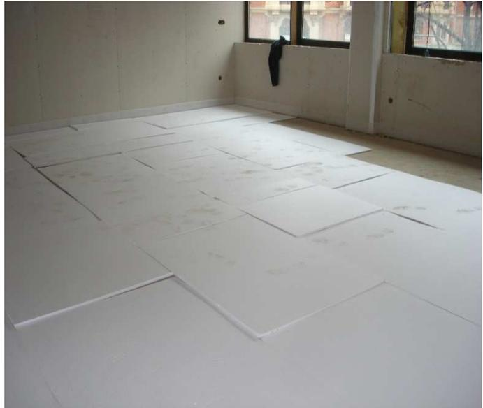
Con estas comprobaciones, y si son necesarias sus correcciones, conseguiremos que el **espesor del mortero sea lo más regular posible, como máximo alrededor de 2-3 cm**. desde la parte superior del elemento que más sobresale del sistema radiante (tetón o tubo), favoreciendo la eficiencia del sistema.
