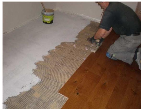
**Paso 7:** colocación del revestimiento
