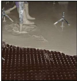
La anhidrita, nombre común con el que se conoce al sulfato cálcico deshidratado ó anhidro, se obtiene en la producción de fluoruro de hidrógeno HF.
